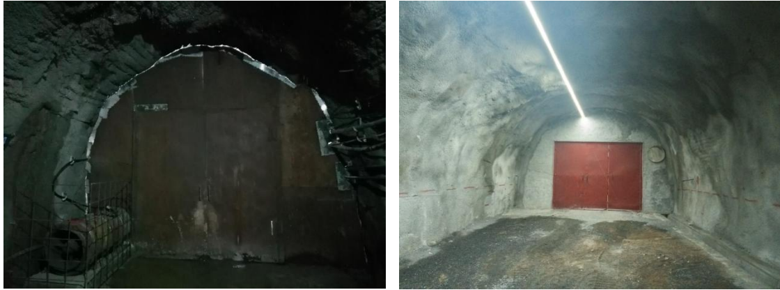
图 2.4-25 通风构筑物
