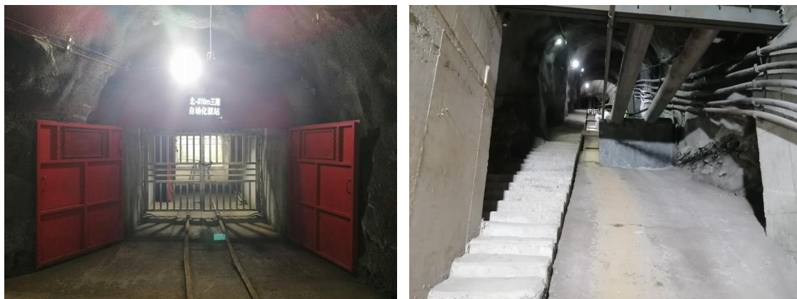
图 2.4-9 北矿带-610m 水泵房硐室安全出口
