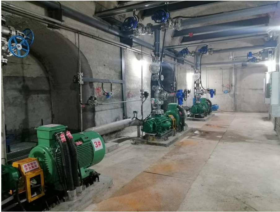
图 2.4-33 粉矿回收水平排水设施
