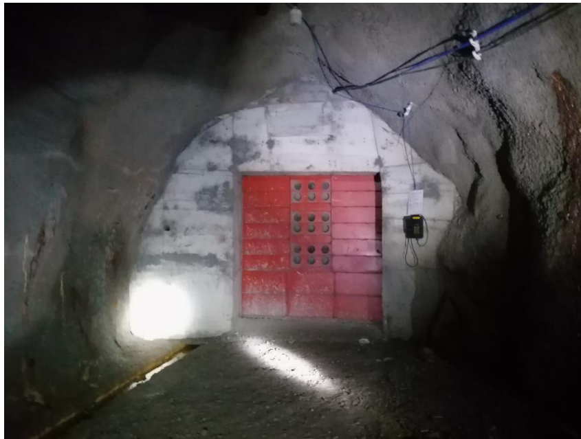
图 2.4-11 爆破器材库
