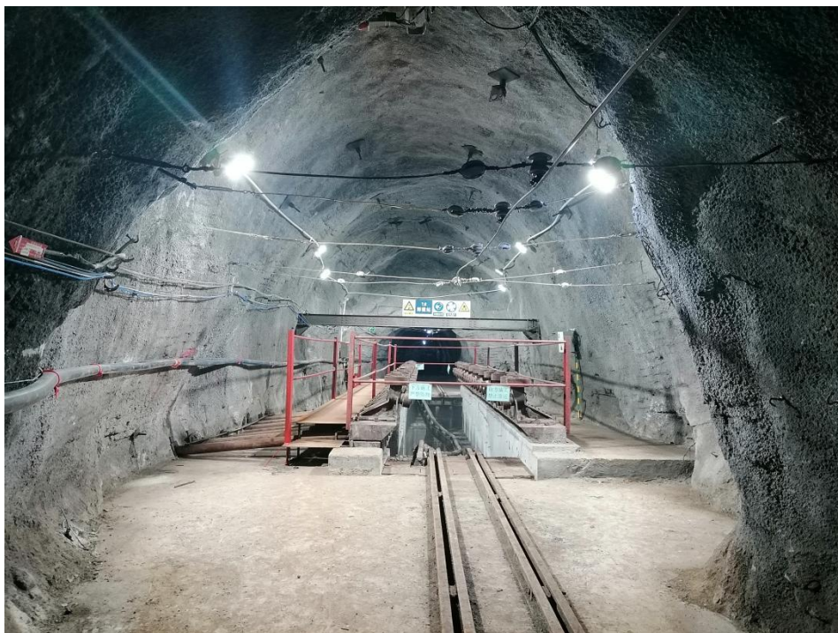
图 2.4-20 主溜井卸载站
