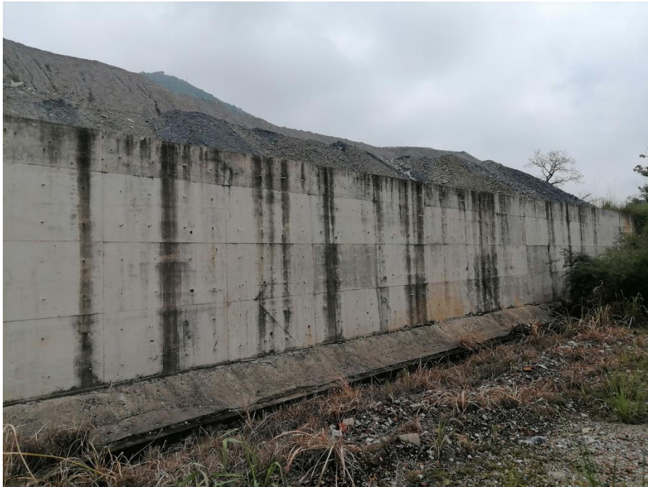
图 2.4-53 废石场挡墙护脚
