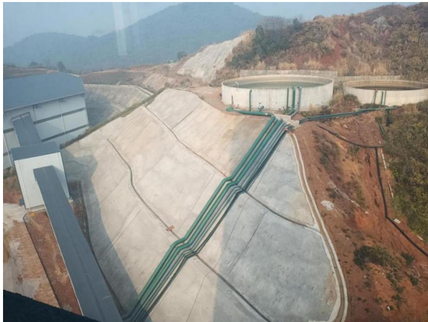
图 2.4-51 采场工业场地边坡治理
