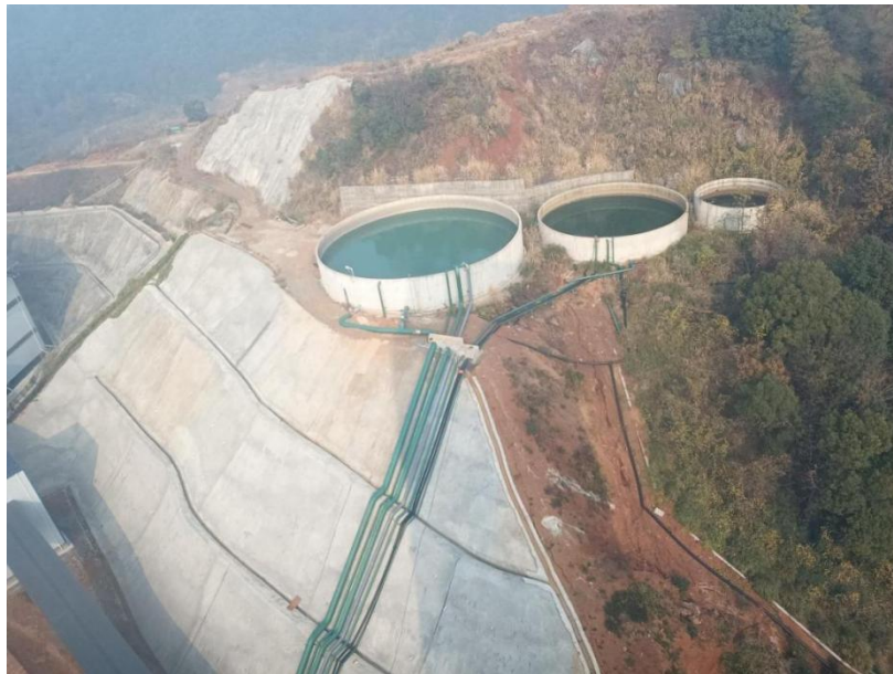
图 2.4-35 南矿带新建 2000m 3 高位水池
