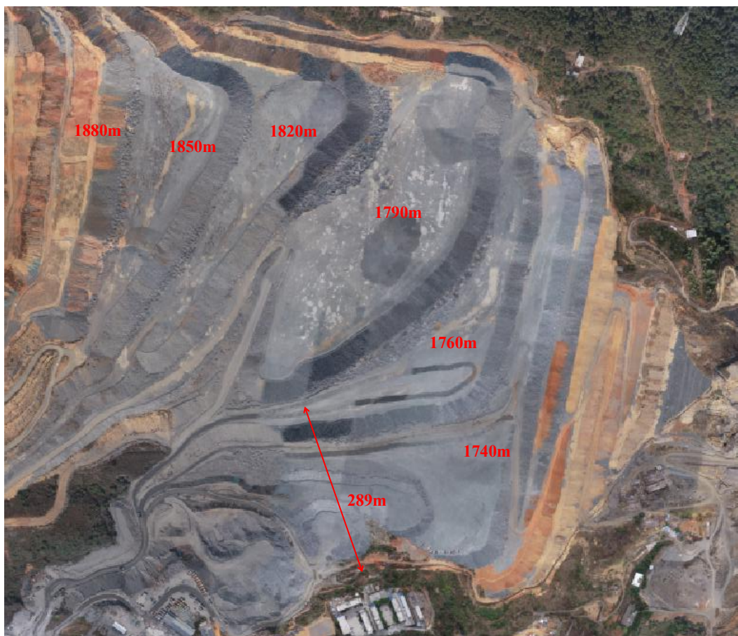
图 2.4.2-7 已排满受土平台现状图
