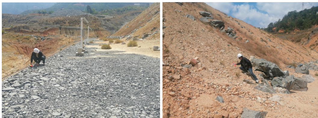
图 2.4.2-5 已排满排土台阶平台、坡面角
