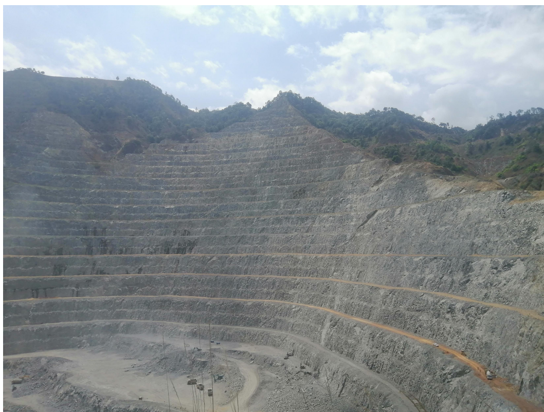
图 2.4.4-4 扩帮区域边坡照片
