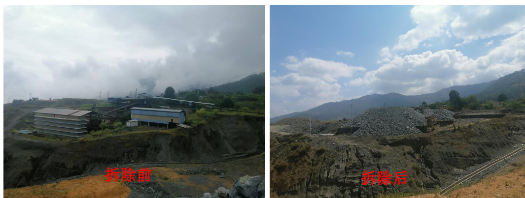
图 2.1-2 尾矿处理设施拆除前后对比照片
