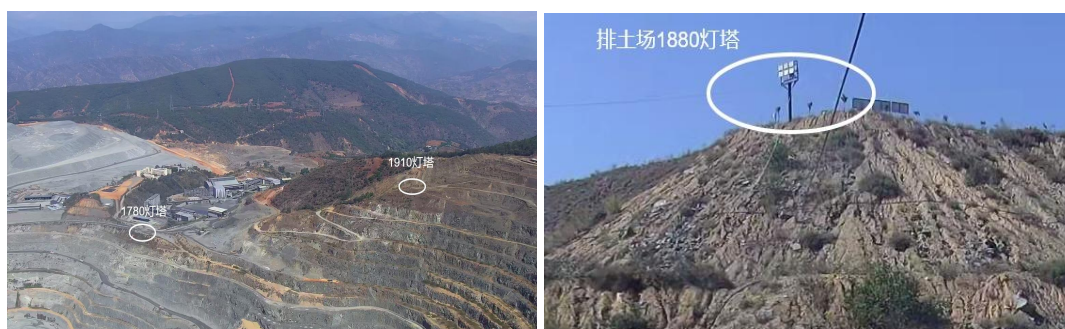
图 2.4.7-2 灯塔照明设施
