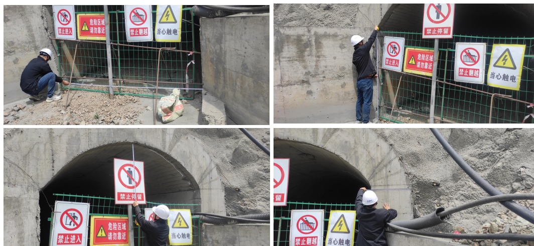
图 2.4.6-9 1750m 排洪隧洞
