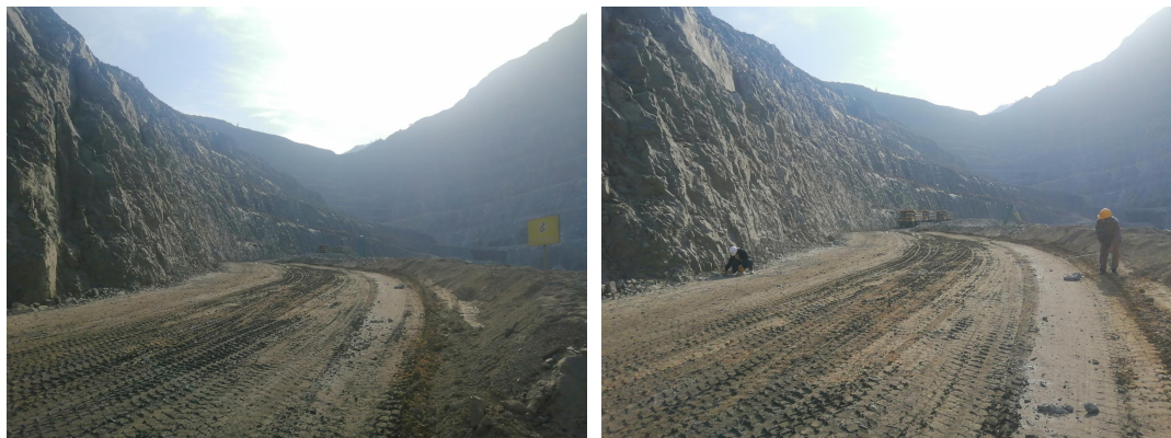
图 2.4.5-3 采场内固定运输道路现场测量照片
