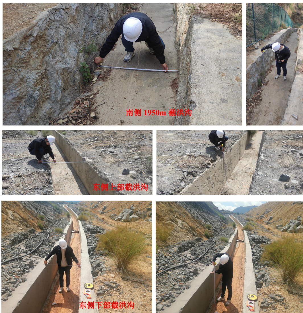
图 2.4.2-8 南侧 1950m、东侧截洪沟现状
