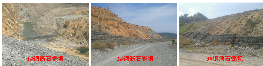
图 2.4.2-15 大田湾排土场钢筋石笼坝
