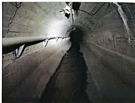
排水隧洞情况
