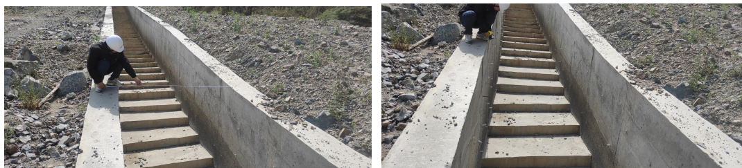
图 2.4.6-4 I#跌水槽现场测量照片
