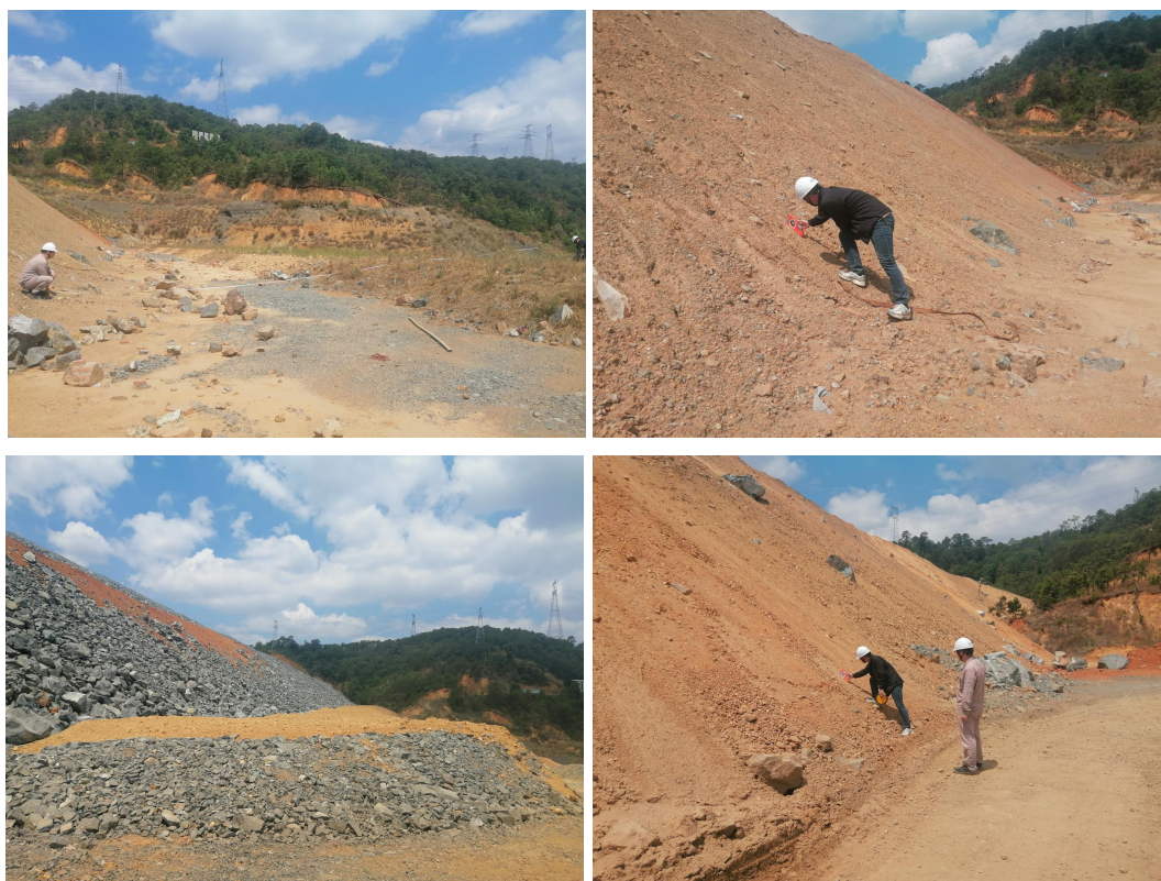
图 2.4.2-6 已排满排土台阶平台、坡面角
