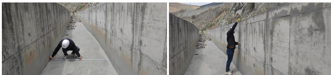
图 2.4.6-7 1750m 平台总排出段截排洪沟
