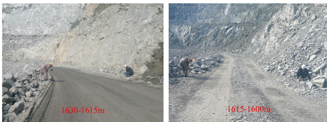
图 2.4.5-4 采场内移动联络道路现场测量照
