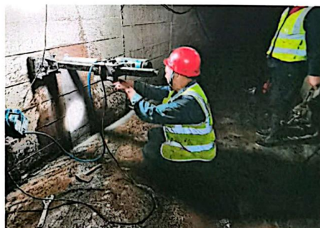
混凝土钻芯取样情况
