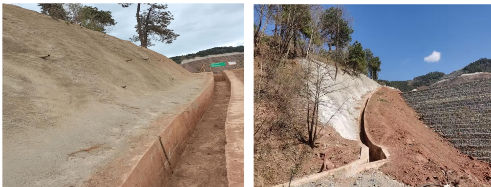
图 2.4.1-5 排土场截排洪设施
