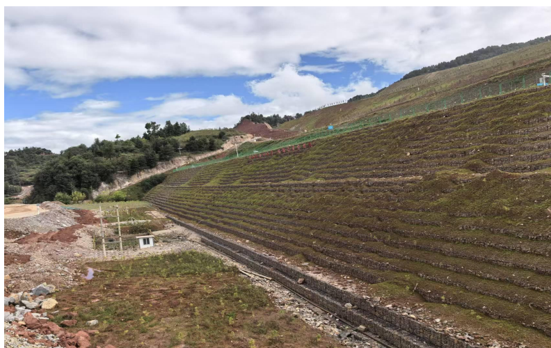
图 2.4.1-6 加筋格宾碾压土石坝
