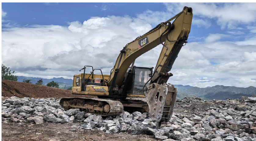
图 2.4.5.2-8 现场二次破碎
