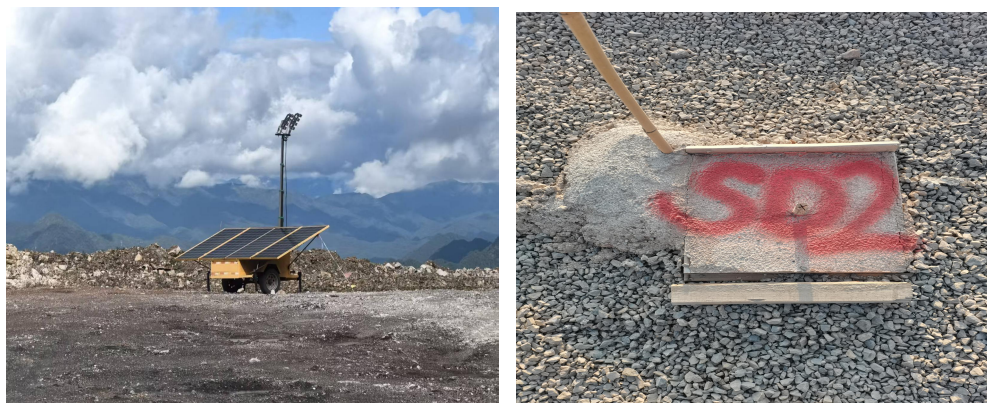
图 2.4.1-7 照明设施，GNSS 监测设施
