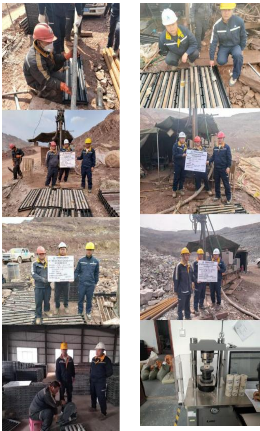
图 2.4.5.2-16 采空区治理充填体现场取芯图
