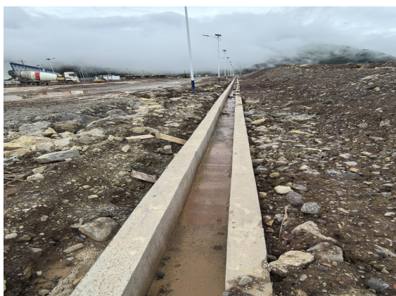
坑口场地排水沟
