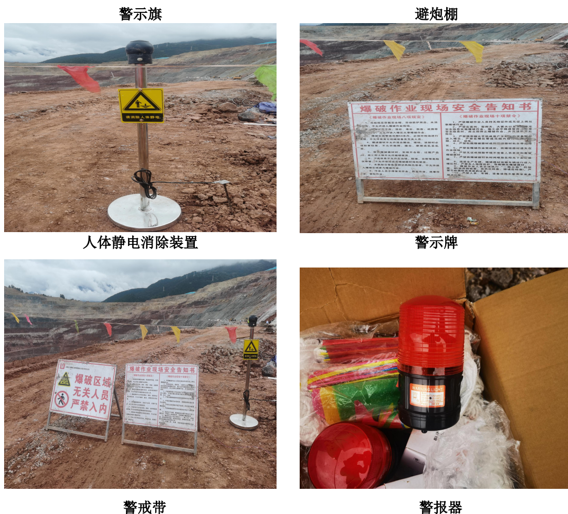
图 2.4.5.2-9 爆破作业相关安全设施
