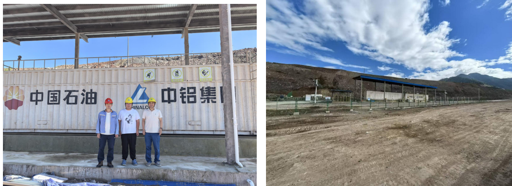
图 2.4.2.3-1 撬装加油站建设完工情况
