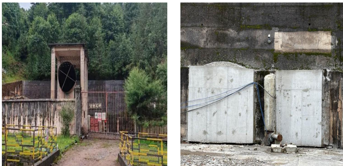
图 2.1.4-3 回风斜井坑口拆除、封堵前后对比照片
