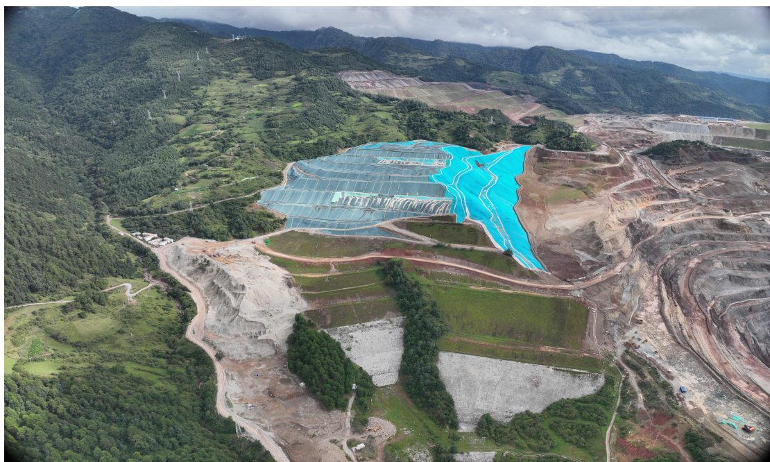
3 号堆场航拍图
