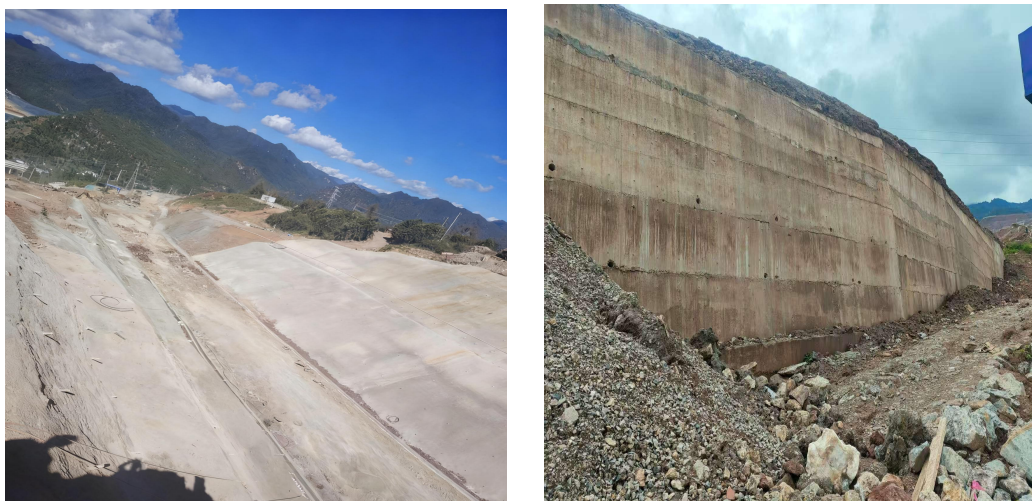
图 2.4.6.1-2 道路边坡防护
