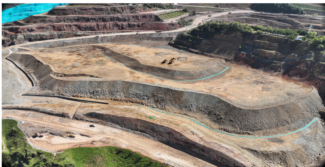
架崖山临时堆场堆场航拍图
