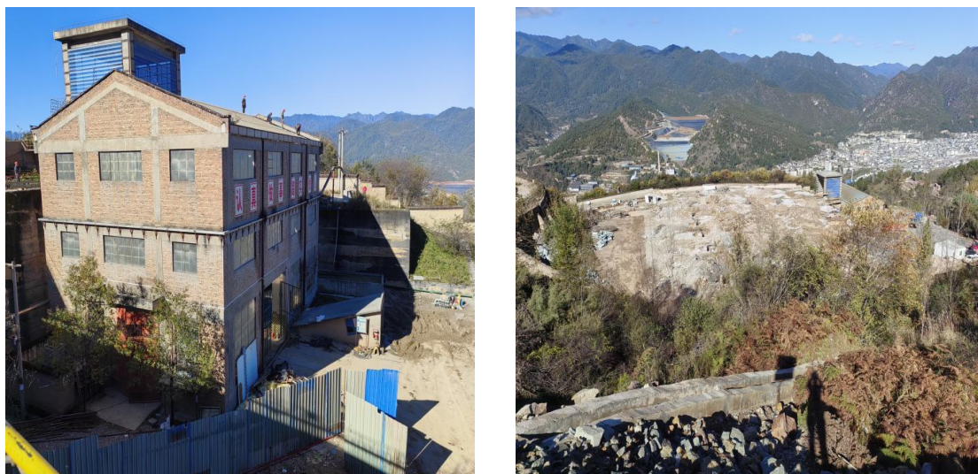
图 2.1.4-2 粗碎站拆除前后对比照片
