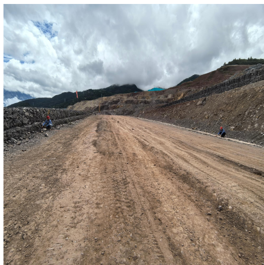
场内运输道路（主干道路）
