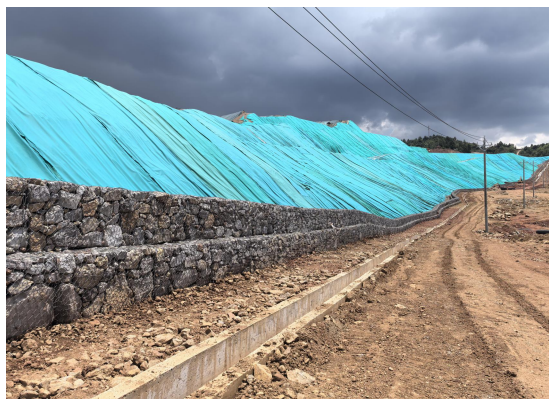
3 号堆场拦挡坝、5 号截洪沟
