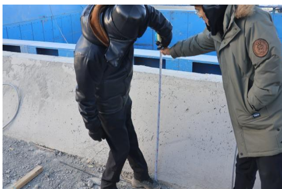
现场实测卸料口车挡高度
