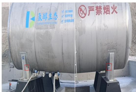
甲醇发罐接地连接点
