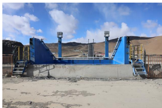
卸料口车挡、照明、视频监控及喷雾降尘装置
