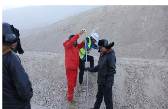
现场实测车挡高度
