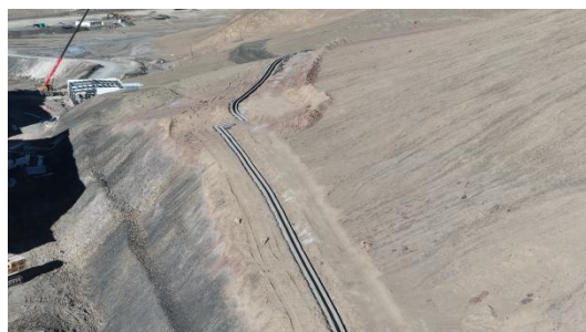
护坡道及坡顶截洪沟
