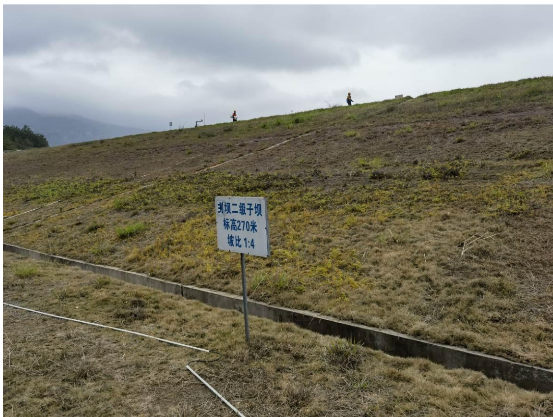
图 2.4-2 主坝堆积坝现状
