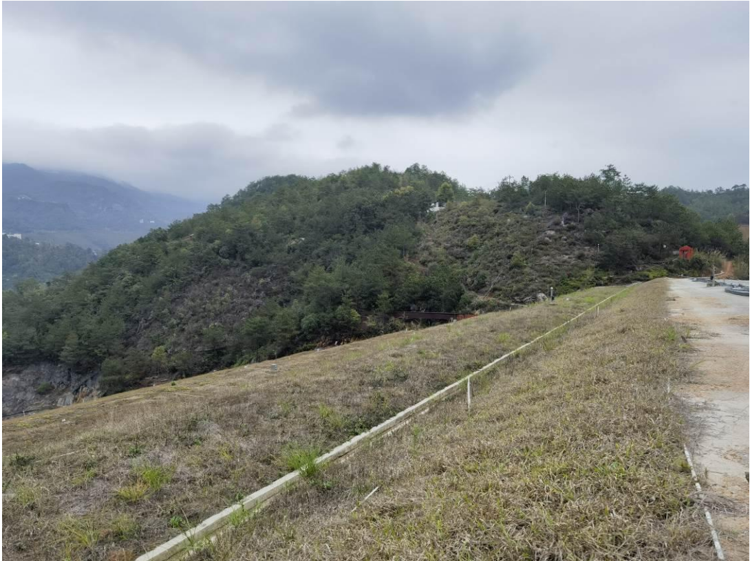
图 2.4-3 副坝堆积坝现状
