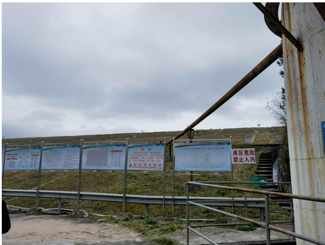
图 2.4-15 现场安全警示标识
