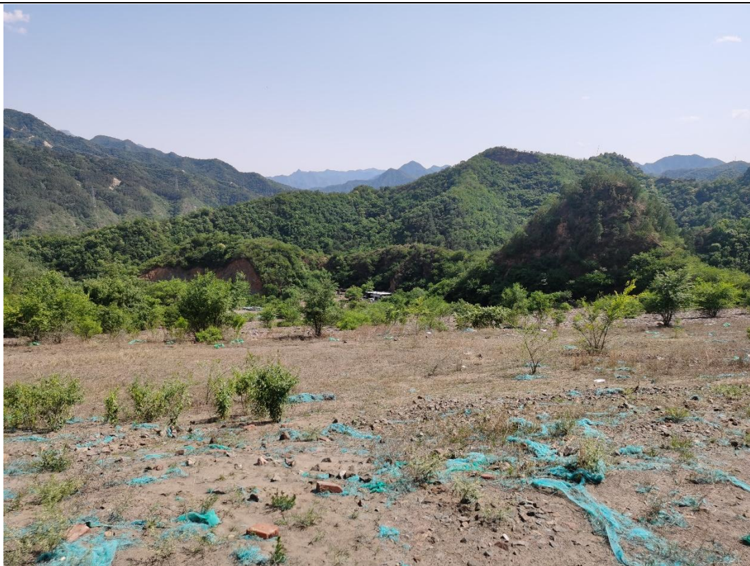
图 2-6 堆积坝外坝坡
