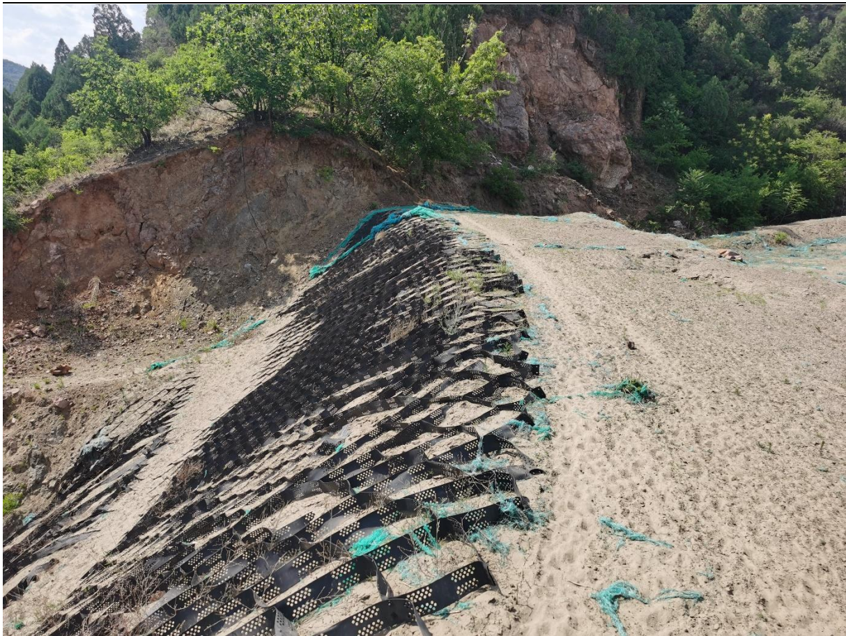
图 2-7 副坝坝体外坡
