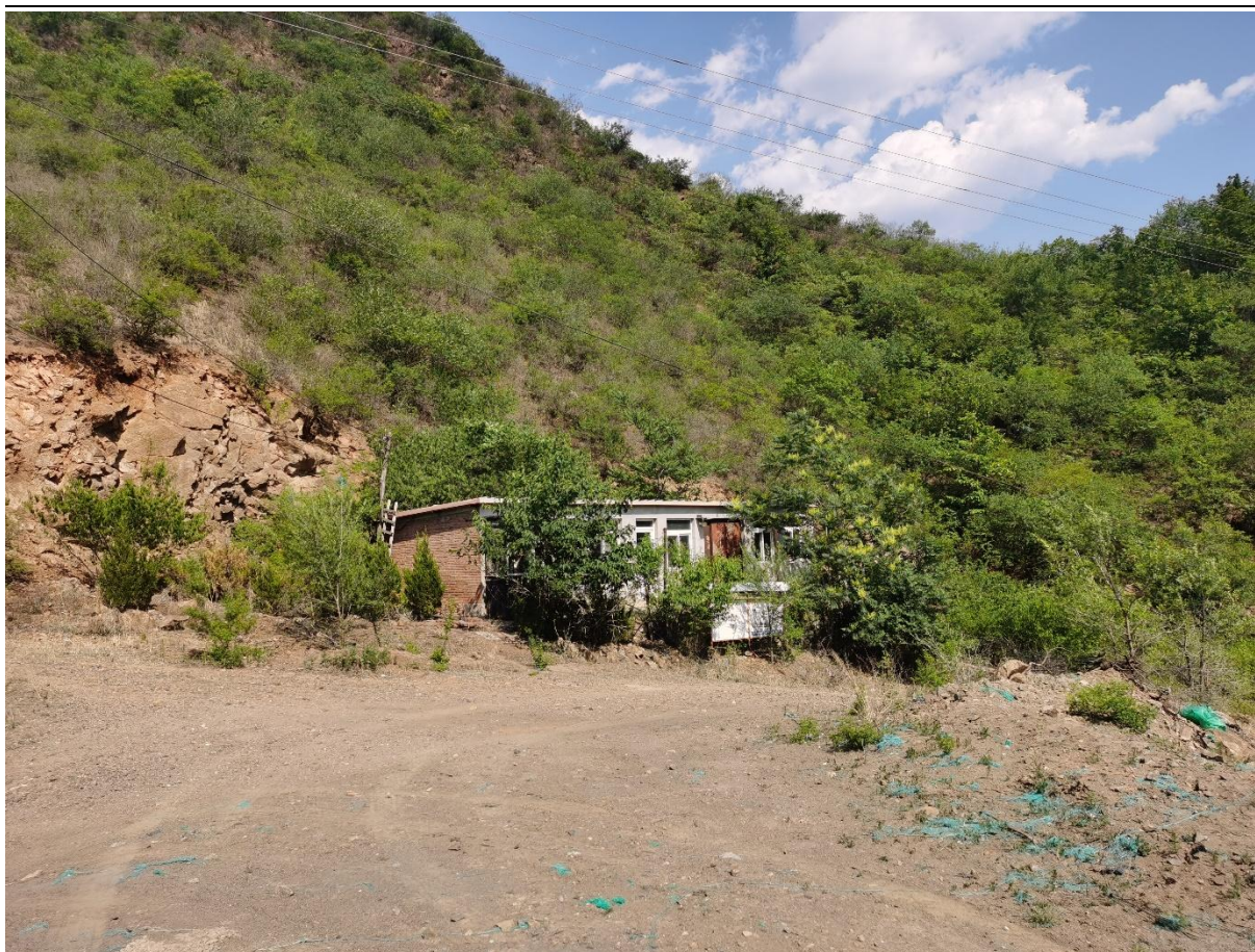
图 2-10 尾矿库原有值班室及上坝道路
