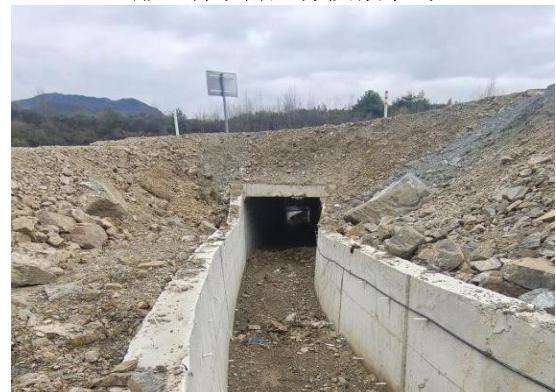
道路箱涵段截水沟（2m×2m）
