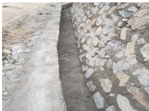
道路内侧浆砌块石排水沟
