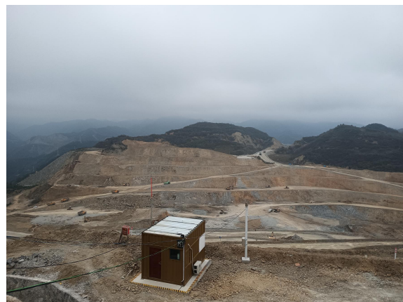
采场北侧边坡
