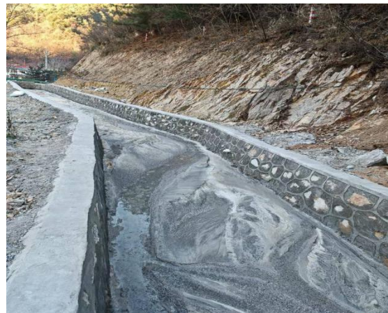
排土场下游延伸段截水沟
