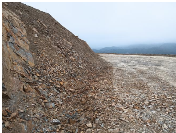
1928m 平台临时排水沟
