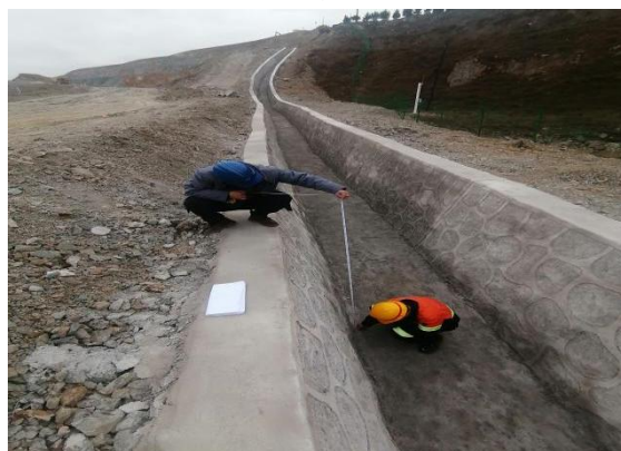
现场实测截水沟尺寸
