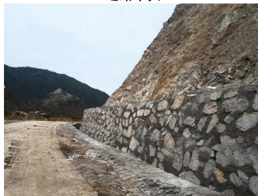
道路边坡加固
