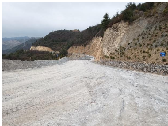
废石运输道路
