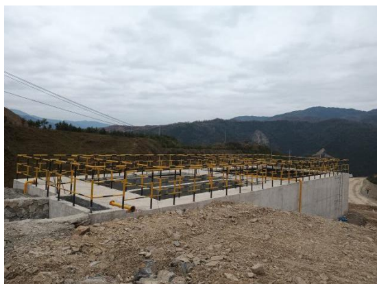
1#采坑涌水沉淀池
