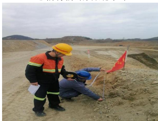
现场实测道路车挡高度
