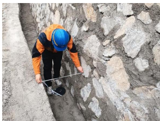
现场实测排水沟宽度
