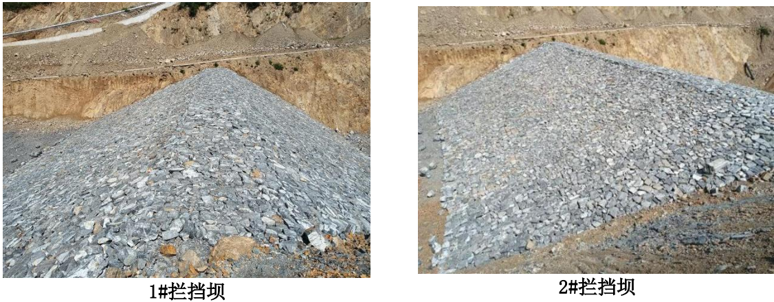
图 2.4-9 排土场拦挡坝建设完工情况
