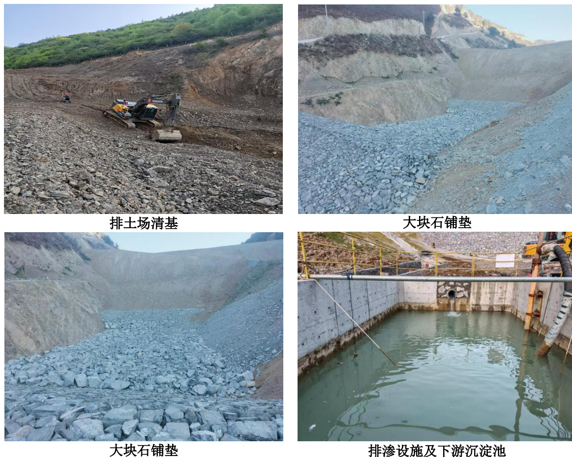
图 2.4-8 排渗设施建设完工情况
