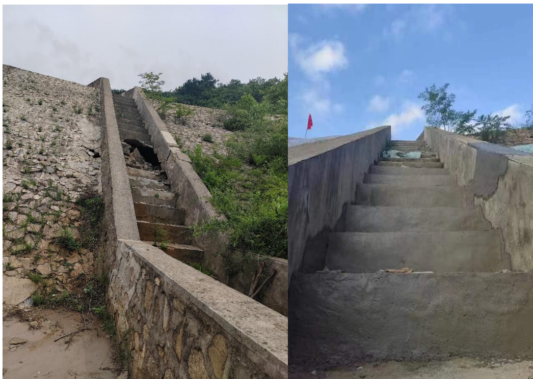
图 2-5 非常溢洪道加固前后照片
