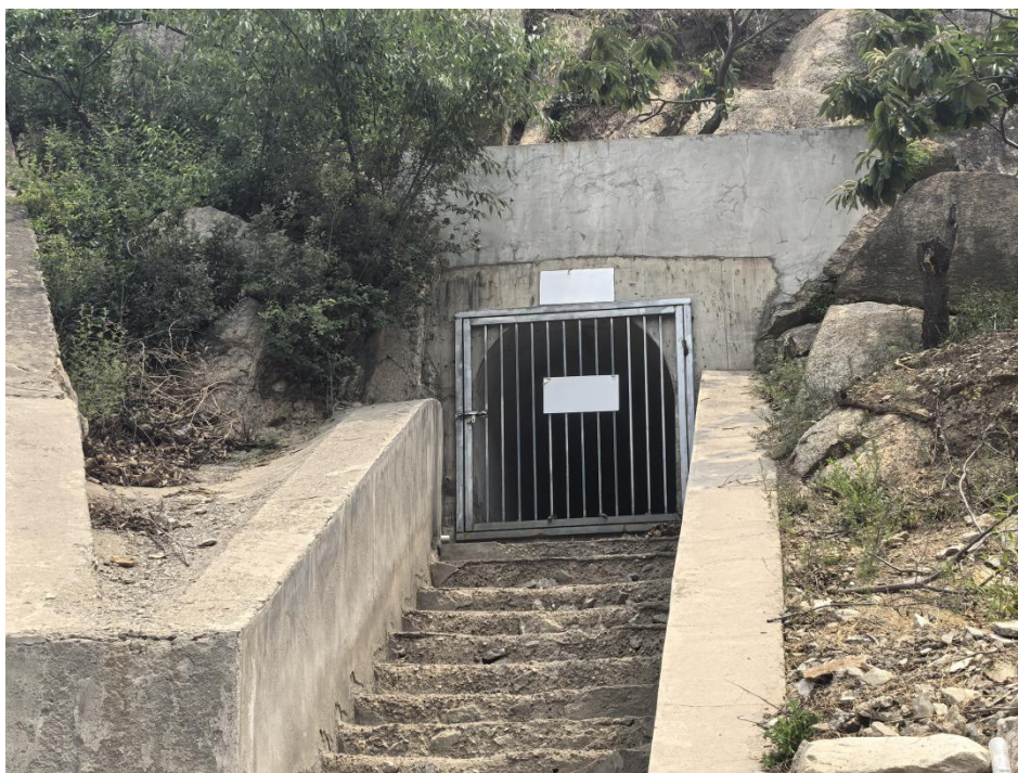
图 2-14 塔-洞排洪系统出口现状
