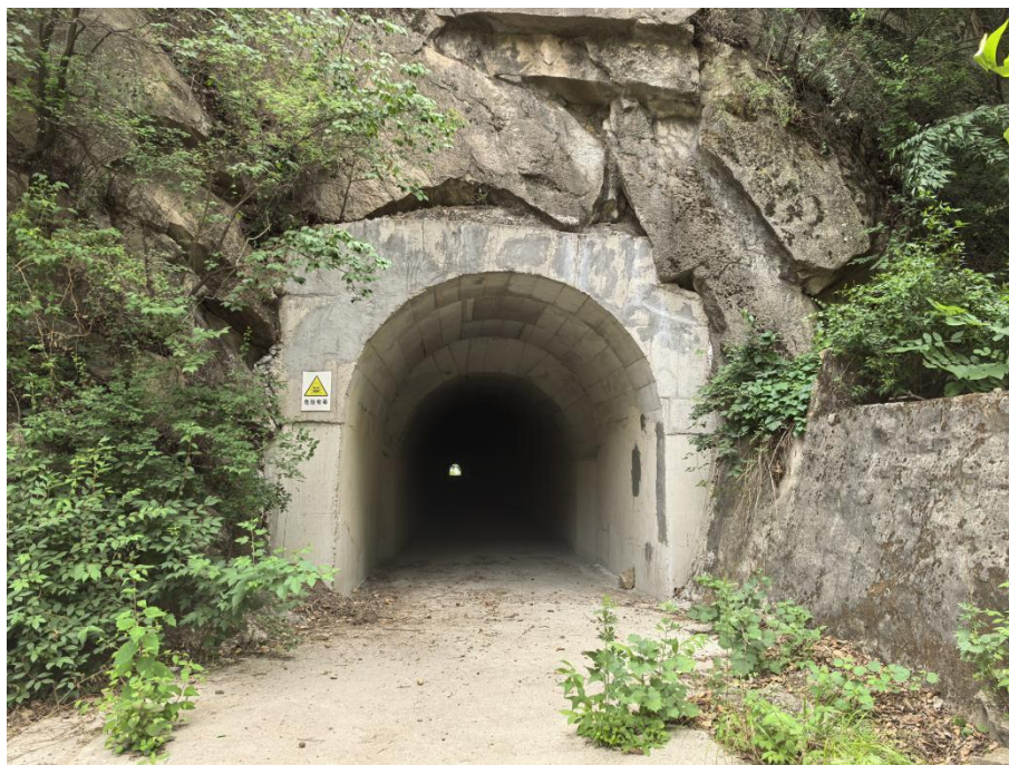
图 2-12 导洪隧洞出口现状
