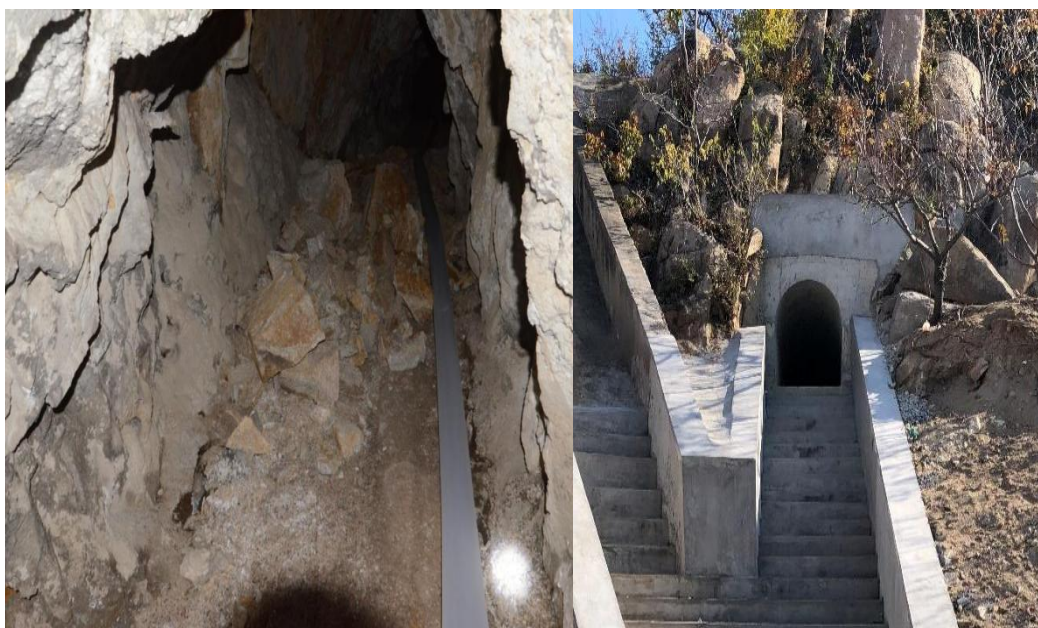
图 2-4 排洪隧洞加固前后照片
