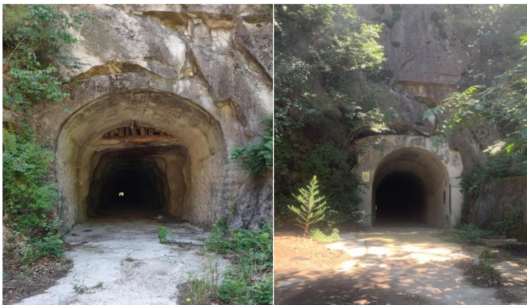
图 2-2 2 号导流洞进口加固前后照片
