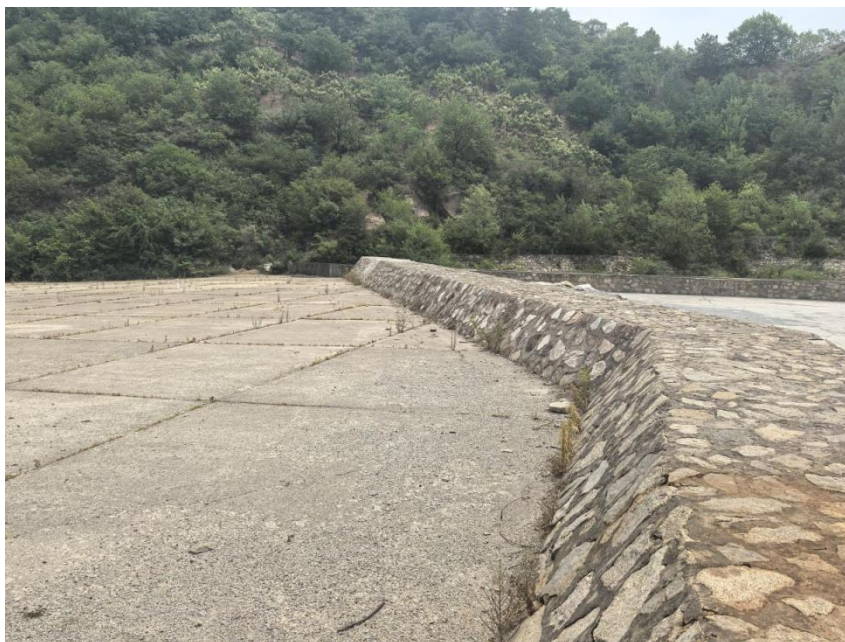
图 2-15 滩顶拦挡坝现状
