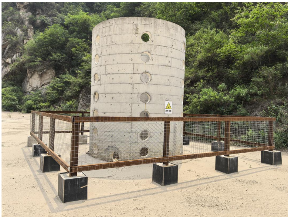
图 2-13 塔-洞排洪系统入口现状
