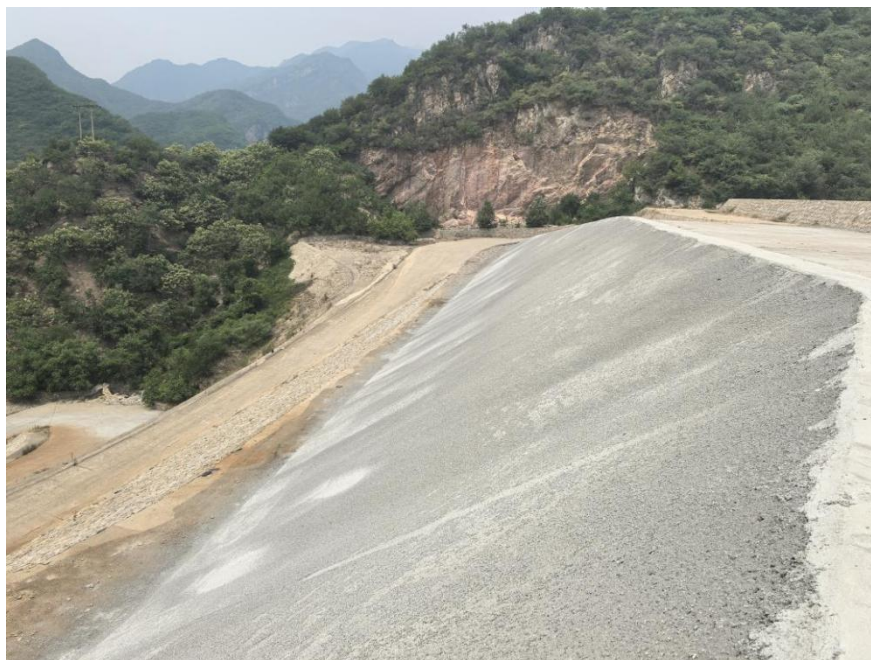
图 2-9 尾矿堆积坝现状
