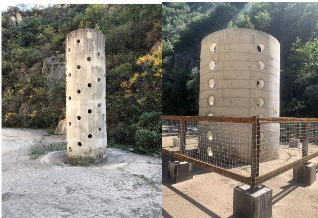
图 2-3 溢水塔加固前后照片
