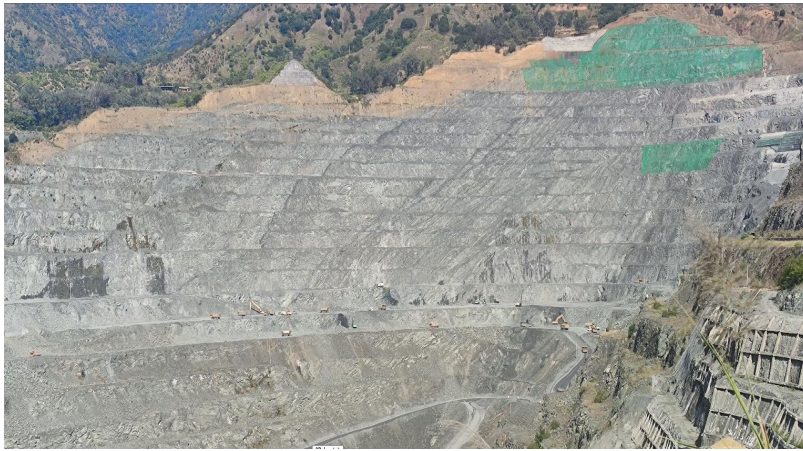
图 2.4.5-3 朱矿采场东端帮北侧边坡
