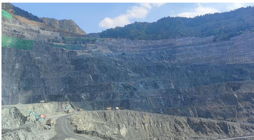
图 2.4.5-1 朱矿采场东端帮南侧边坡
