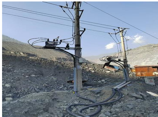
图 2.4.8-2 双电源架空线路
