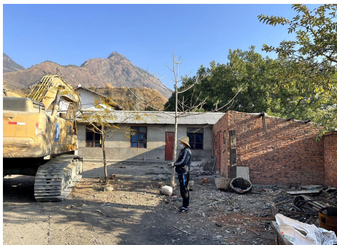
图2.4.5-9 搬迁前现场照片
