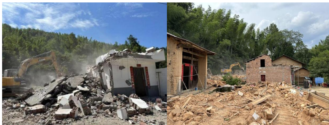
图 2.1-3 现场拆迁照片
