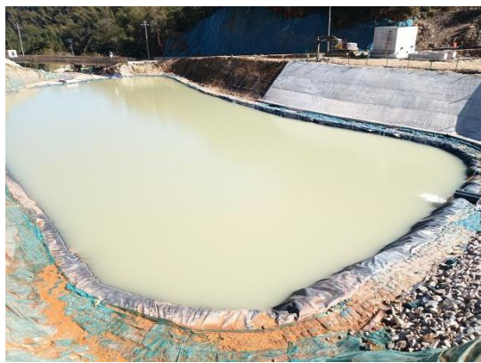
排土场下游淋滤液收集池
