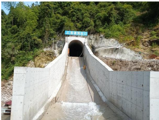
连通隧洞出口明渠
