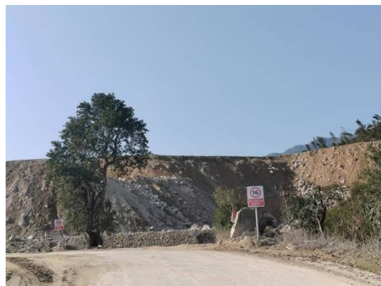
排土场安全警示标志
