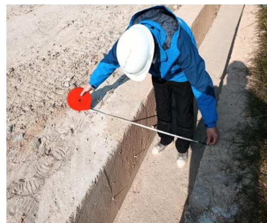
现场实测水沟尺寸
