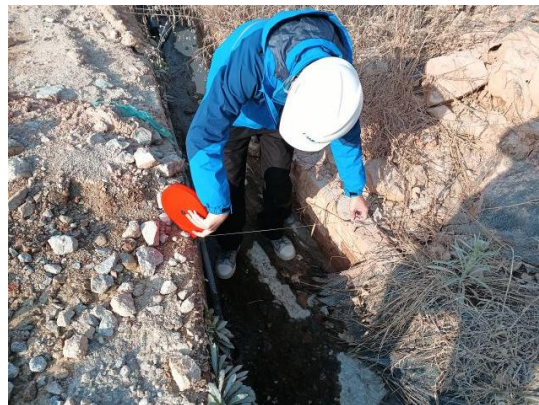
现场实测排水沟尺寸
