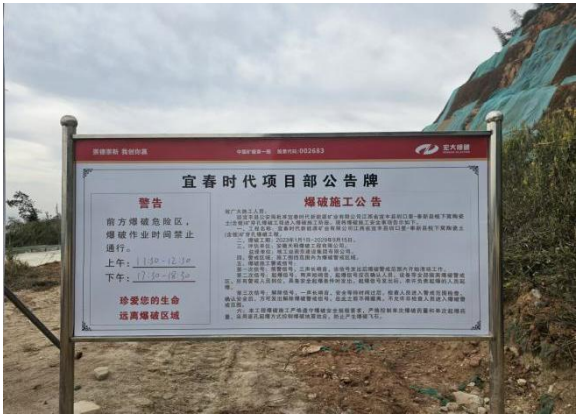
爆破安全告知牌
