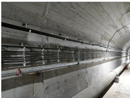
胶带斜井内电缆敷设情况
