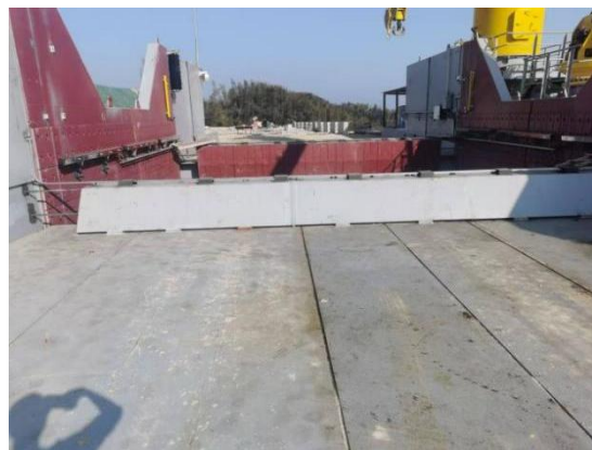
废石破碎站卸料口车挡
