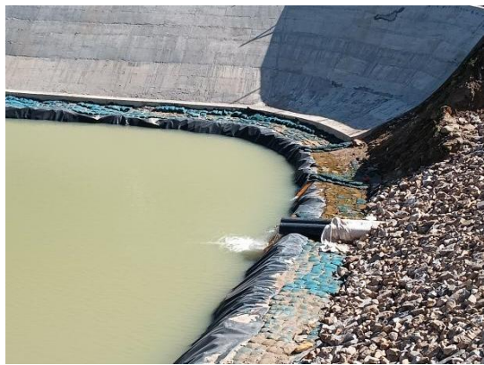
排土场底部排渗盲沟
