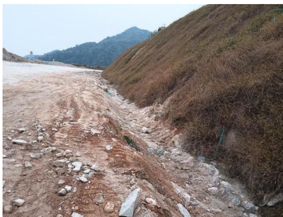
矿石运输道路排水沟
