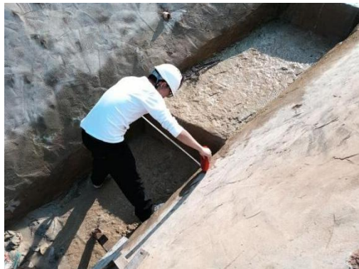
现场实测排水沟尺寸
