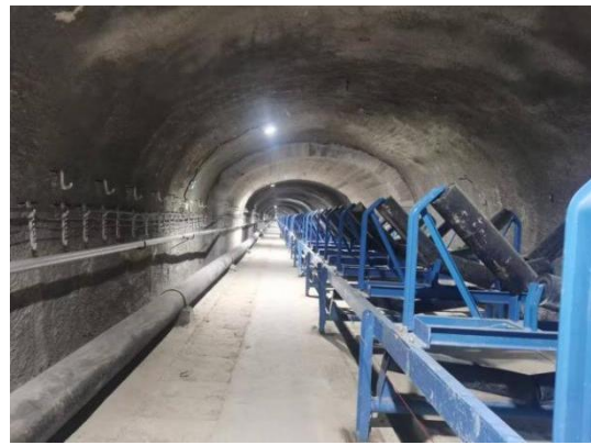
胶带斜井支护情况
