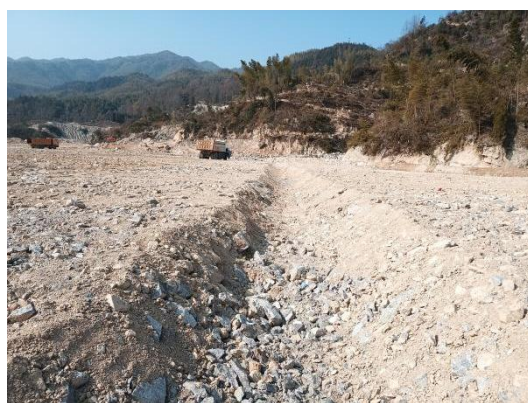
平台临时排水沟
