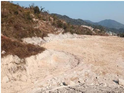
排土场两侧临时排水沟
