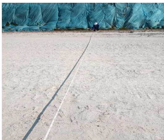
现场实测路面宽度
