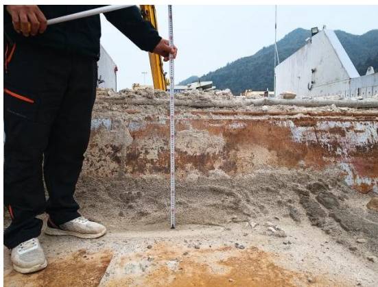
现场实测卸料口车挡高度
