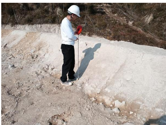
现场实测排土场车挡高度
