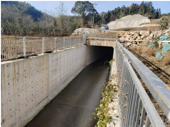
排洪主隧洞下游暗涵及明渠
